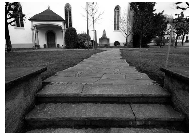
Der sanierte Plattenweg verbindet die Kirche mit dem Gemeindehaus.
