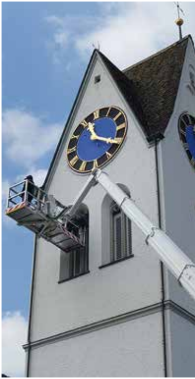
Montage in luftiger Höhe.
